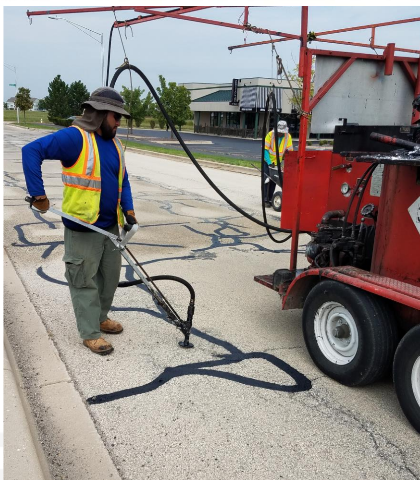
Crack Fill
